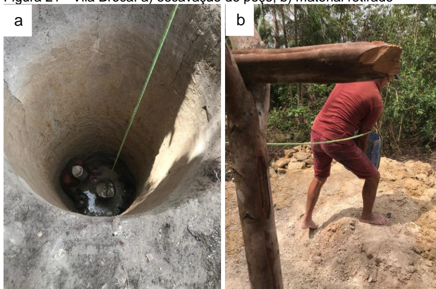
Figura 21 - Vila Broca: a) escavação de poço; b) material retirado
